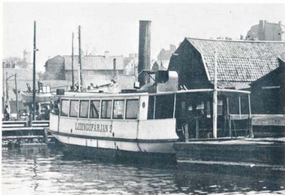
LIDINGÖFÄRJAN 2 blev så småningom FÄRJAN 6. På bilden som är från 1927 ligger färjan vid Hamnens varv vid Kusten i Göteborg. Lägga märke till att färjan har fällbar skorsten. Foto från Sjöfartsmuseet.
